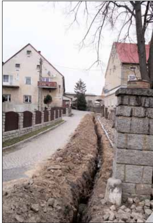
Rozbudowa sieci wodociągowej w Chroślicach
