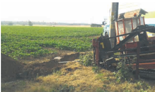
Rozpoczęła się również budowa sieci wod-kan na Osiedlu Piotrowice
