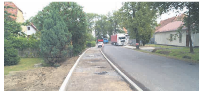
Już niebawem mieszkańcy Chełmca poruszać się będą bezpiecznym chodnikiem
